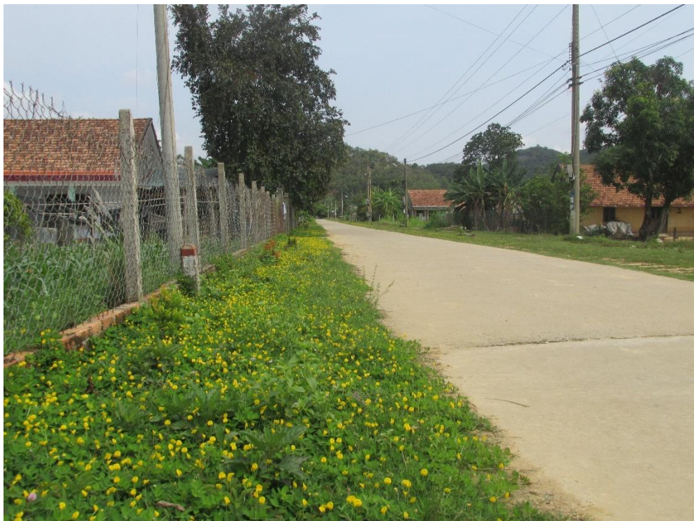
Hình 31. Đường bê tông (xã Phước Cát 2, huyện Cát Tiên)
